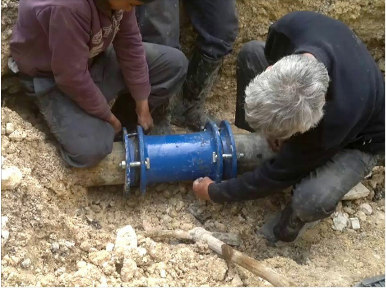
الإدارة العامة لديها فريق لإصلاح الأضرار في أنابيب المياه وأسلاك الكهرباء (الجزيرة نت)
