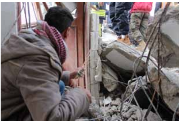
بعد القصف الذي استهدف مبنى الهلال الأحمر في مدينة إدلب | سوريانا
