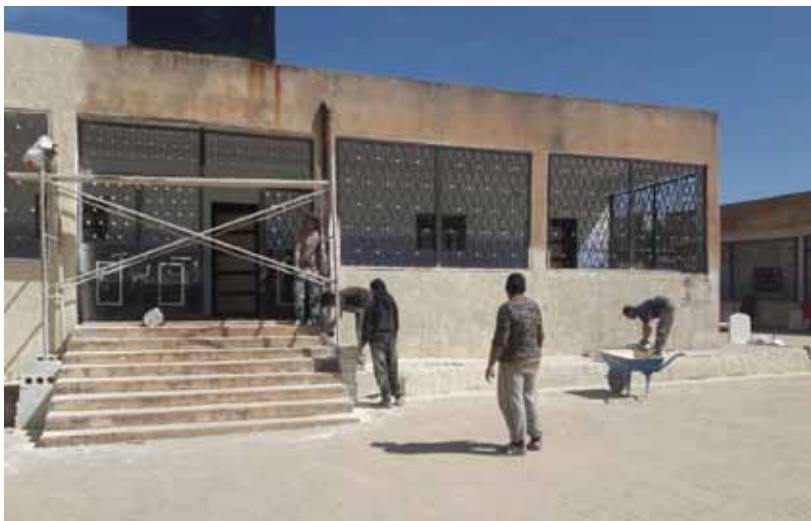
من عمليات ترميم مدرسة «سنا الربيع» في إدلب | سوريتنا
