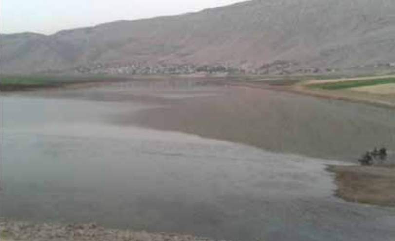
سد قسطون شمال سهل الغاب بعد جفافه | سوريتنا
