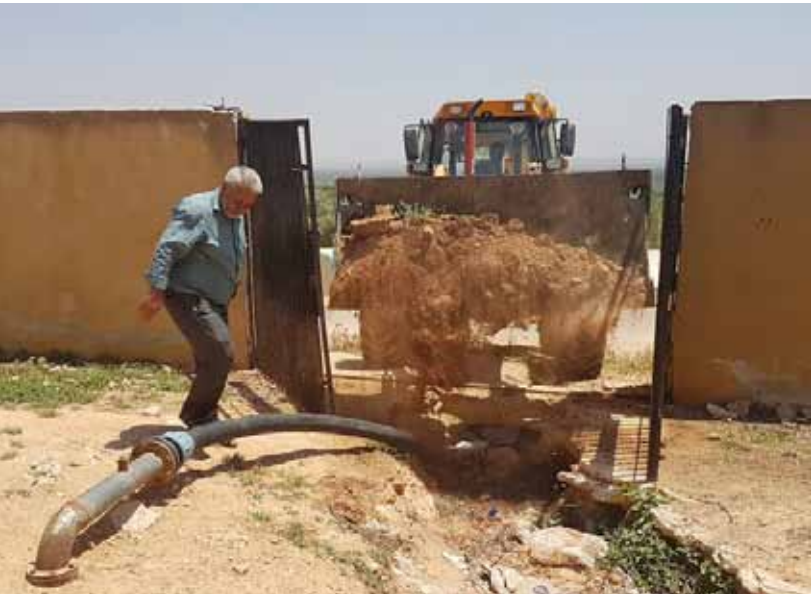
أثناء قيام مؤسسة المياه في مدينة إعزاز بإصلاح مولدة ضخ المياه | المجلس المحلي
