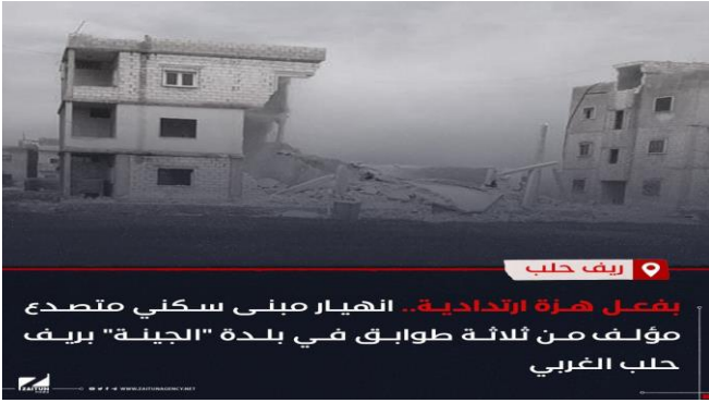
بفعل هزة ارتدادية.. انهيار مبنى سكني متصدع مؤلف من ثلاثة طوابق في بلدة "الجينة" بريف حلب الغربي
