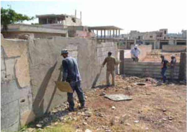
أثناء أعمال ترميم المدارس في الرستن | سوريتنا
