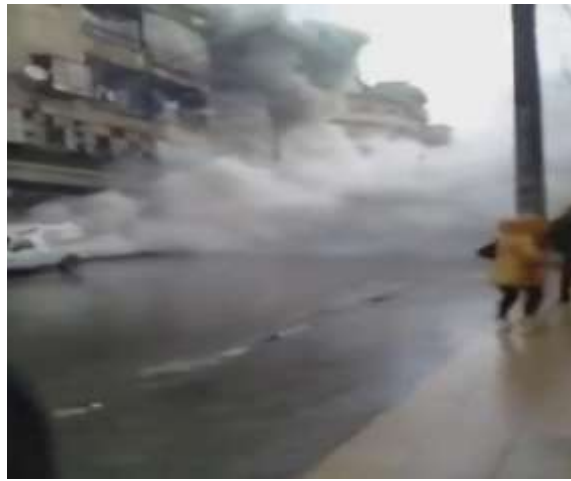
لحظة انهيار مبنى بمدينة حلب - الكلاسة
