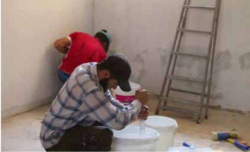
أثناء ترميم المنازل في مدينة معرة النعمان | المجلس المحلي
