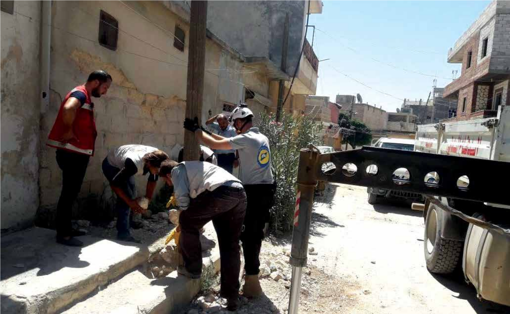
الدفاع المدني يقوم بصيانة أعمدة الكهرباء في مدينة إعزاز – تويتر
