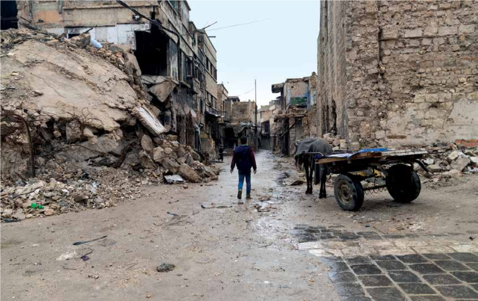
من الصعب جداً ترميم الأبنية المتصدعة في أحياء حلب الشرقية نتيجة وجود شروخ كبيرة فيها (صدى الشام – أرشيف)
