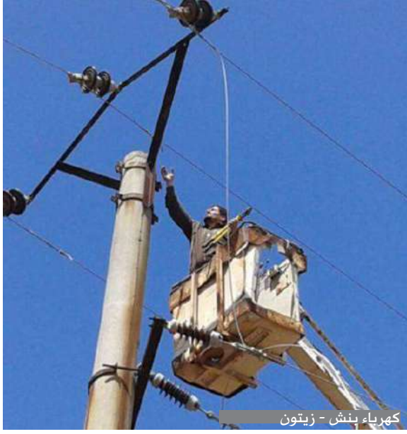
كهرباء بنش - زيتون
