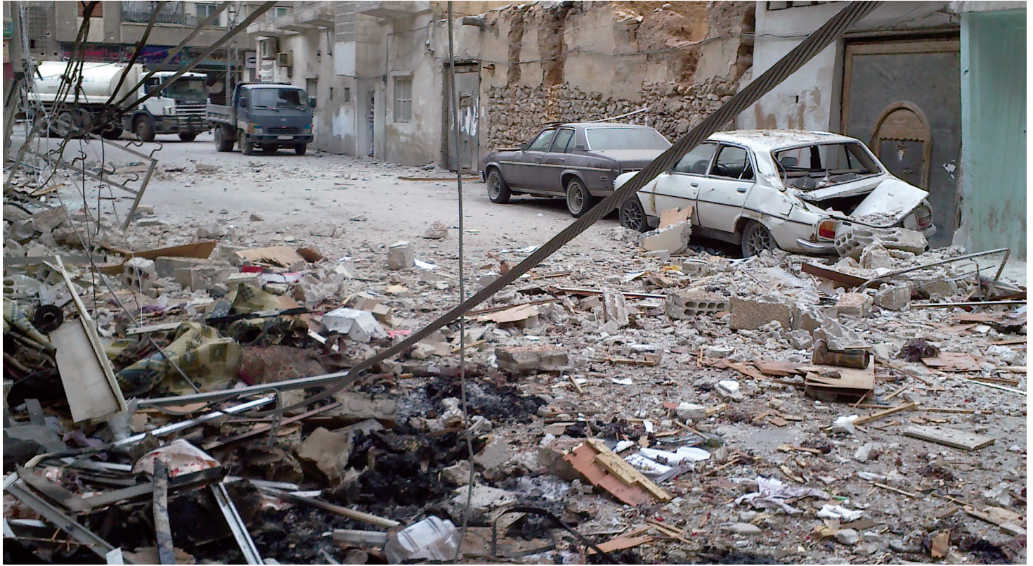
آثار القصف الجوي بطائرات الميغ لمحيط المدرسة المحدث للبنات - داريا 18 تشرين الثاني 2012
