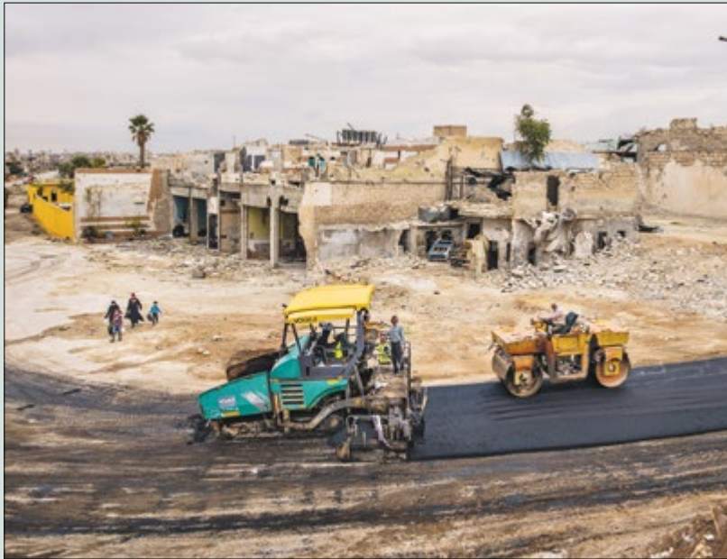
عمال بناء يقومون بعمليات التفتيت بالقرب من مطار حلب شرق حلب- شباط 2019 (ناشيونال جيوغرافيك)
