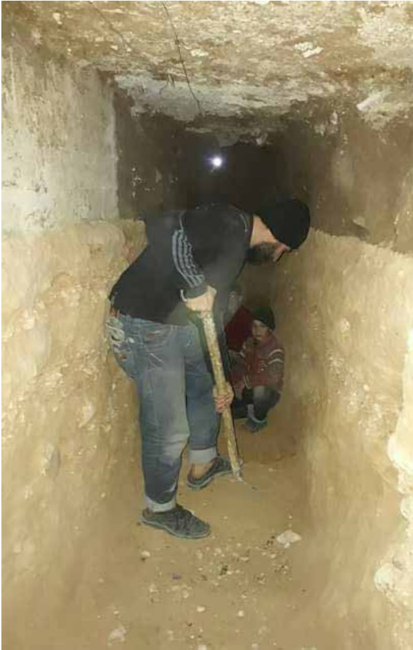
شبان من أهالي بلدة حمورية أثناء حفر نفق للاستخدام المدني | شباط 2018 | سوريثنا
