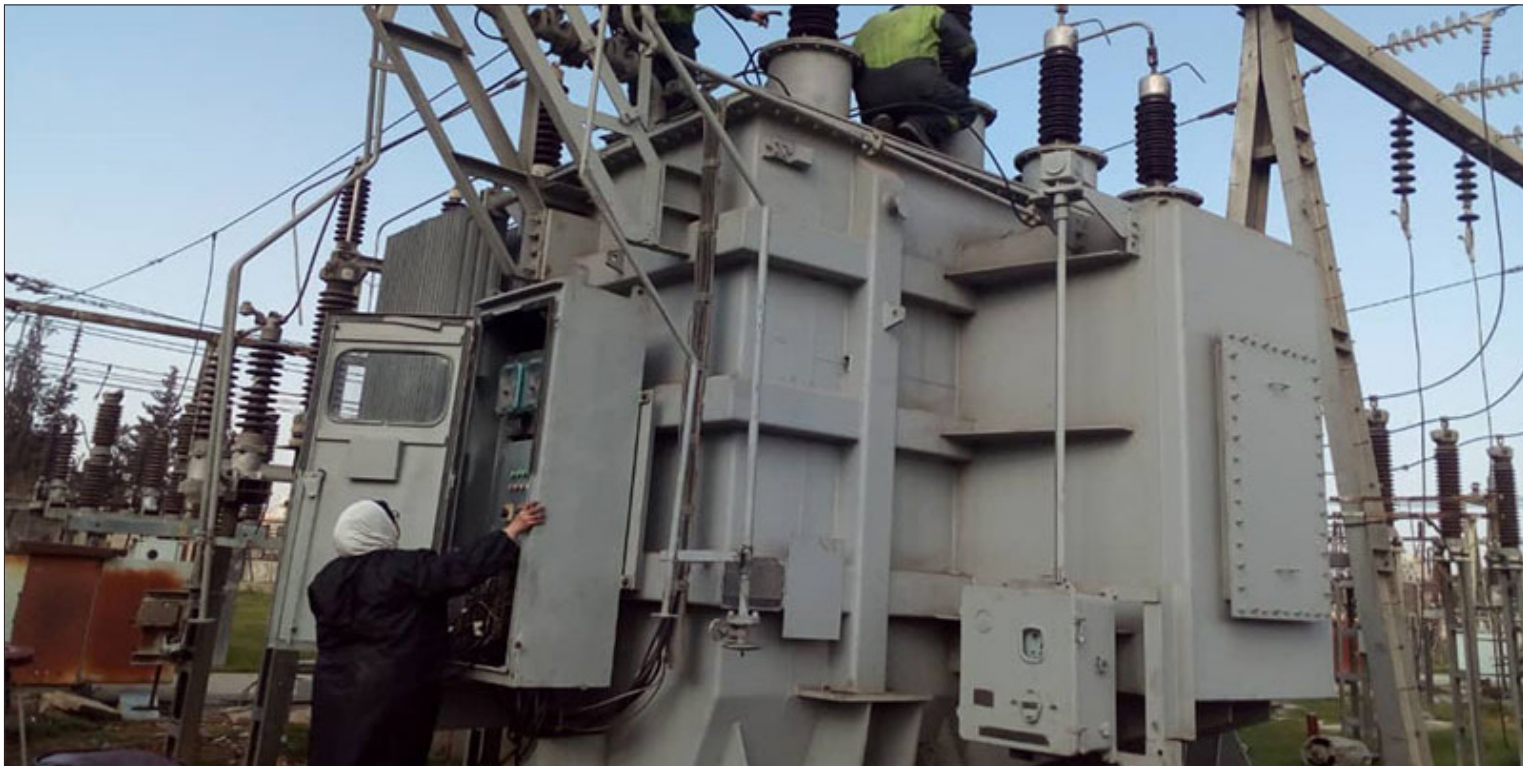
أعمال إصلاح المنظومة الكهربائية في حلب شمالي سوريا من قبل موظفي وزارة الكهرباء السورية - 18 من آذار 2021 (صفحة "وزارة الكهرباء" عبر "فيس بوك")
